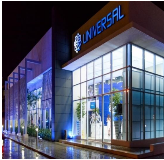
Edificio Universal Zona Oriental
