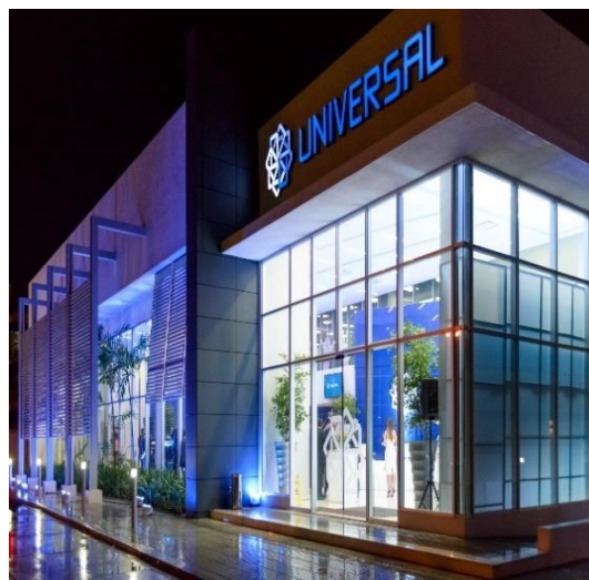
Edificio Universal Zona Oriental
