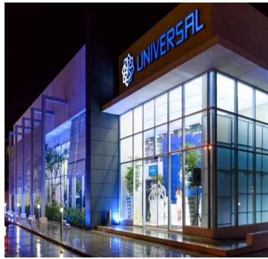
Edificio Universal Zona Oriental
