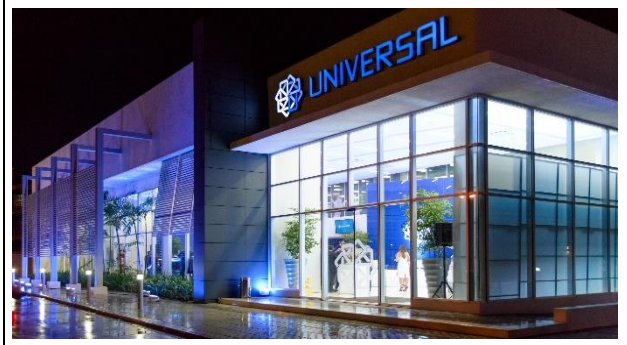
Edificio Universal Zona Oriental
